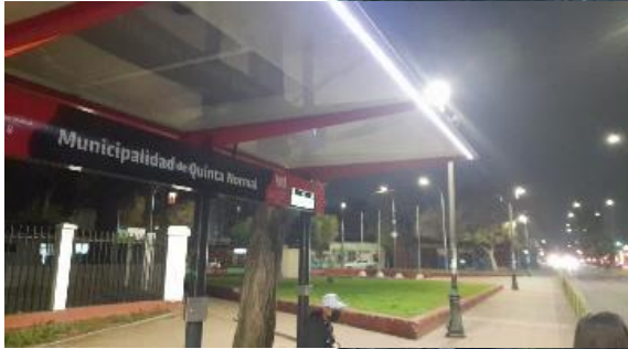
Sistema de iluminación solar
