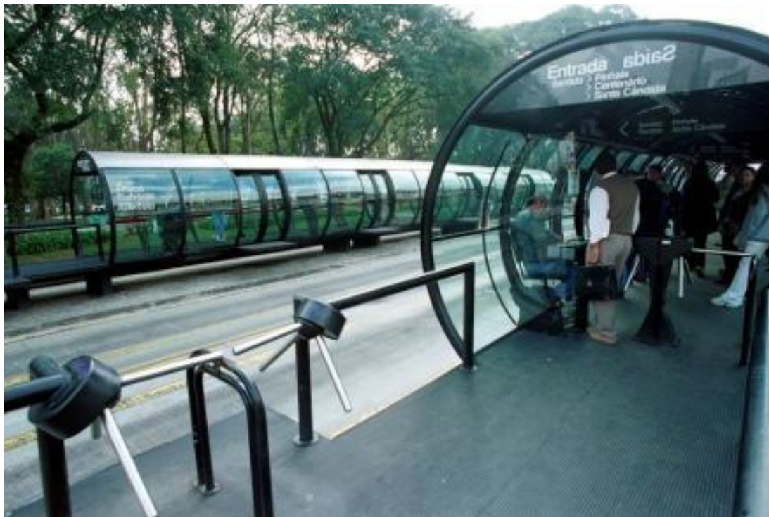
Figura 3.45: Estación-tubo en Curitiba
