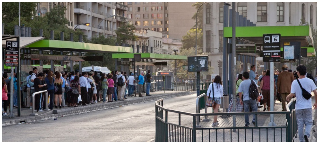
3. Refugio Tipo Corredor Estructura sobredimensionada que dificulta su inserción en el espacio público. Fuente: Archivo DTPM
